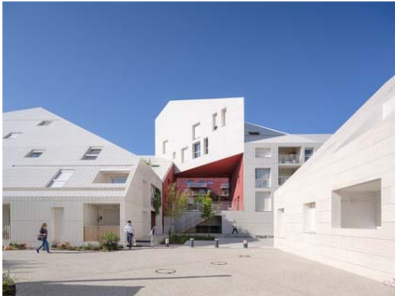
Image 7 Source: agrob-buchta1.de / Ossip Architectuurfotogr. Rotterdam
