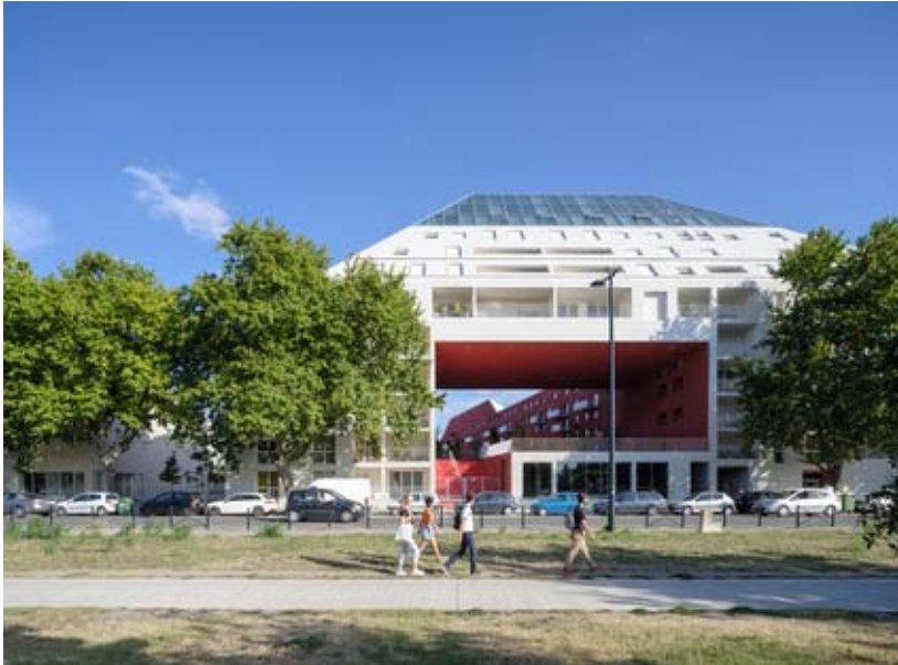
Image 6 Source: agrob-buchta1.de / Ossip Architectuurfotogr. Rotterdam
